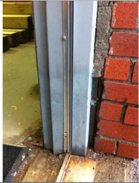
Photo #10: Exterior Door Jamb
