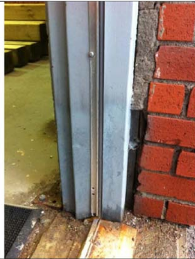
Photo #10: Exterior Door Jamb
